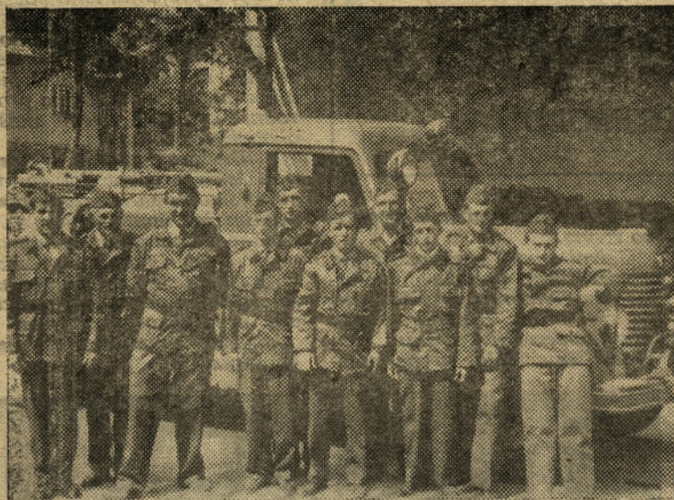
Delavci obrata Prebold kot aktivni in požrtvovalni gasilci gasilske čete Groblja
