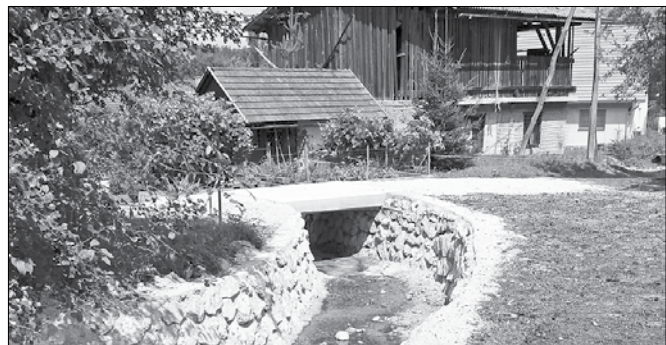
Namesto prejšnjega lesenega so zgradili betonski most. (Fotodokumentacija Občine Nazarje)
