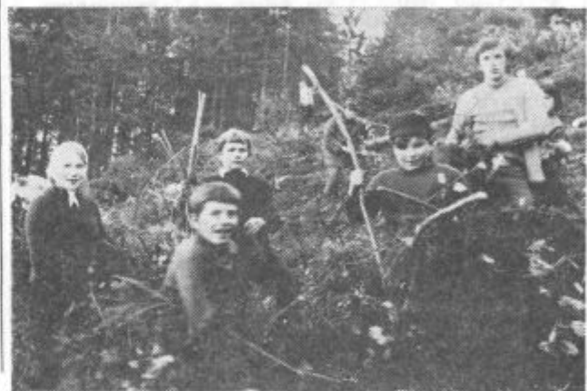
Solarji iz obeh šoštanjskih šol so pomagali v Zavodnjah pri gradnji žičnice
