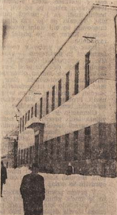
Pročelje gimnazije v Kočevju (Foto: Jože Primc)
