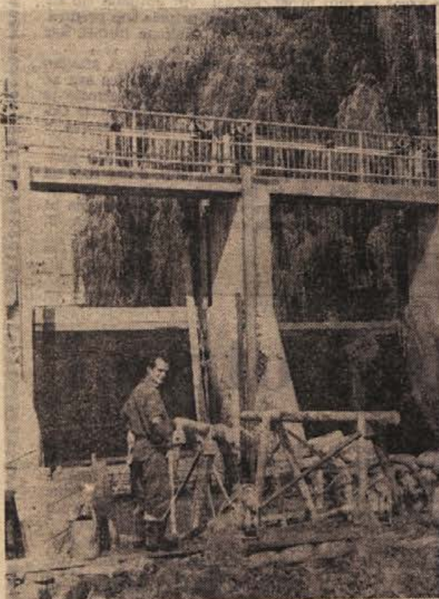
Nove zapornice grade na Rinži v Kočevju. Delo ovira voda, ki teče skozi stare, dotrajale zapornice in otežuje betoniranje. Foto: Primo
