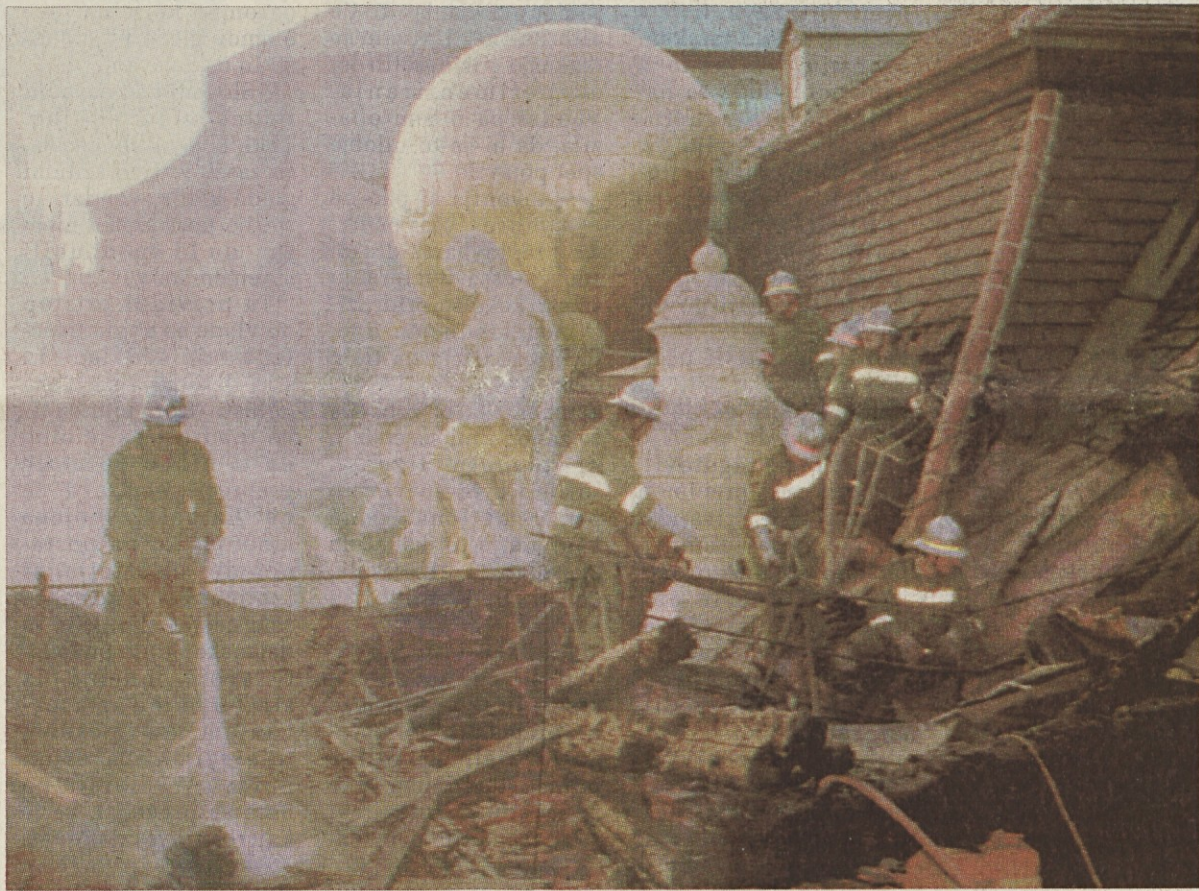
Gasilci na delu med zgošenimi tramovi na strehi Hofburka (Telefoto AP)
