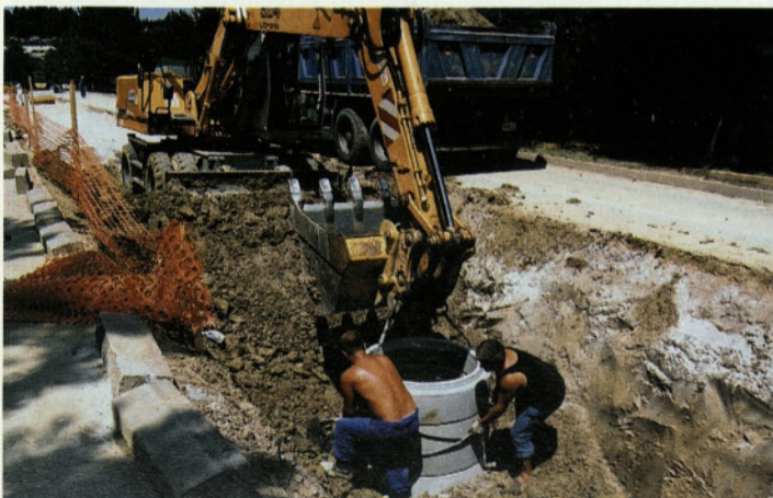
Gradnja kanala v naselju Gorica gre h kraju, krajani Splitske ceste pa bodo zagotovo rešeni strahu pred poplavljanjem meteornih in komunalnih voda. Foto: Jože Miklavc
