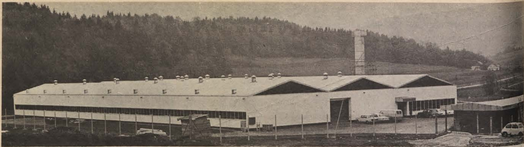
Pogled na novo tovarniško halo DONITA v Veliki Loki pri Trebnjem.
