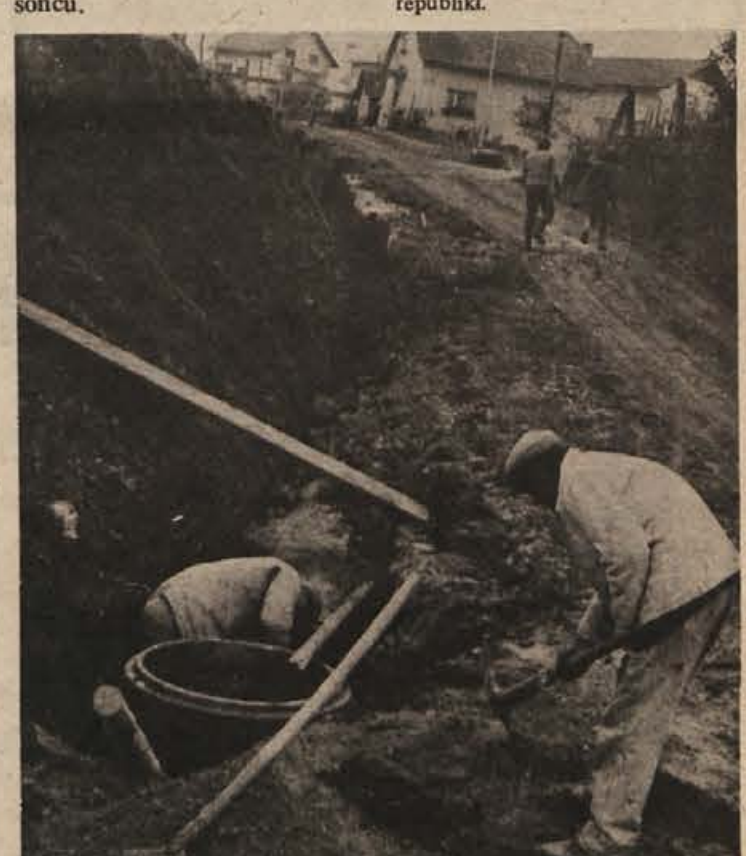
V Šentlovrencu so minuli petek položili asfalt. V Trebnjem pa so delavci v Ulici herojev kljub slabemu vremenu nadaljevali z delom. Na sliki: zaključna dela pri kanalizaciji.
