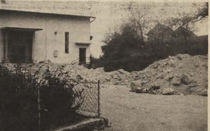
Še danes je pred suhorsko osnovno šolo pravo gradbišče, čez dober teden pa bodo učenci in učence že lahko tekali po težko pričakovanem asfaltu. Veliko zaslug za "prevleko" imajo matična osnovna šola v Metliki, suhorski obrat IMV, krajevna skupnost in krajanje, ki so s prostovoljnim delom privarčevali precej denarja. Na sliki: dvorišče pred šolo je bilo še pred sedmimi dnevi polno gromozov.
