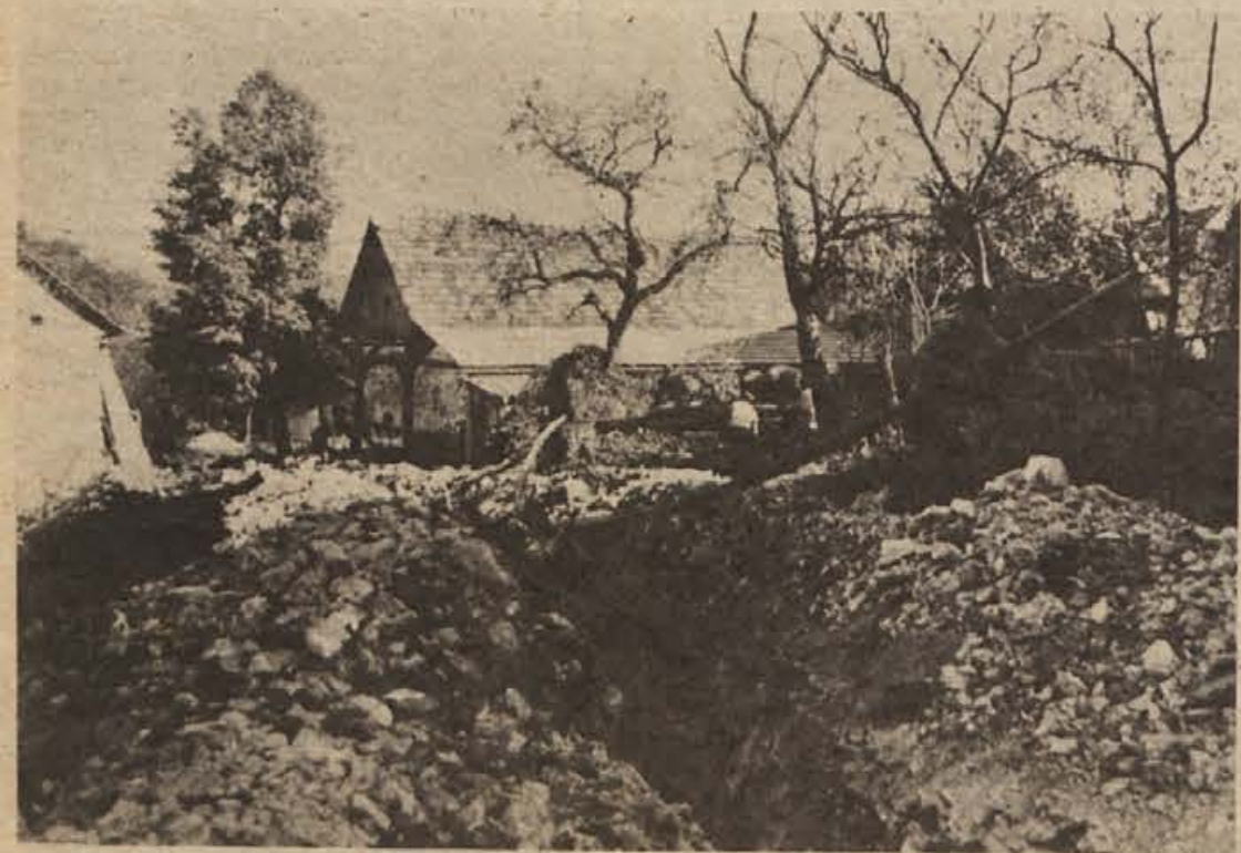
Gradnja vodovoda na Radovici, ki ga gradi Transportno gradbeno podjetje iz Metlike.
