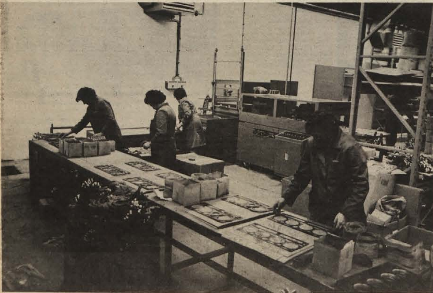
Pripravljanje kompletov tesnil, ki jih zatem avtomatski pakirni stroj ovije v pakirno folijo.
