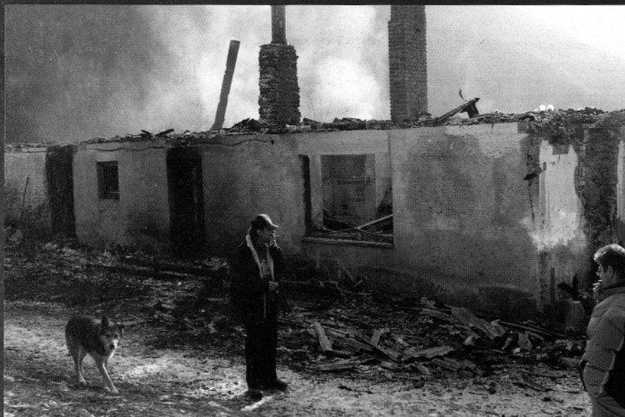
Dan po požaru je bil pogled na hišo, od katere so ostali le še zidovi in dva dimnika, pretresljiv (foto: Štefi Sem)
