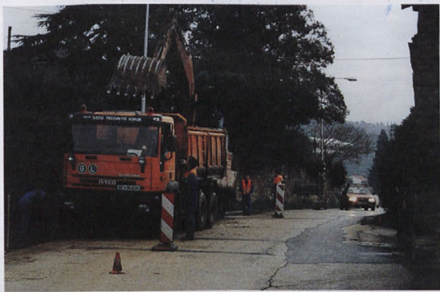
Na sliki: Delavci Cestnega podjetja Koper pripravljajo zemljišče za prvih 250 m pločnika na Liminjanski cesti pod stolpiči 87-91.
