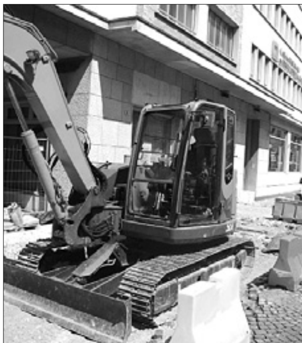
Gradbišče v Ulici Diaz
