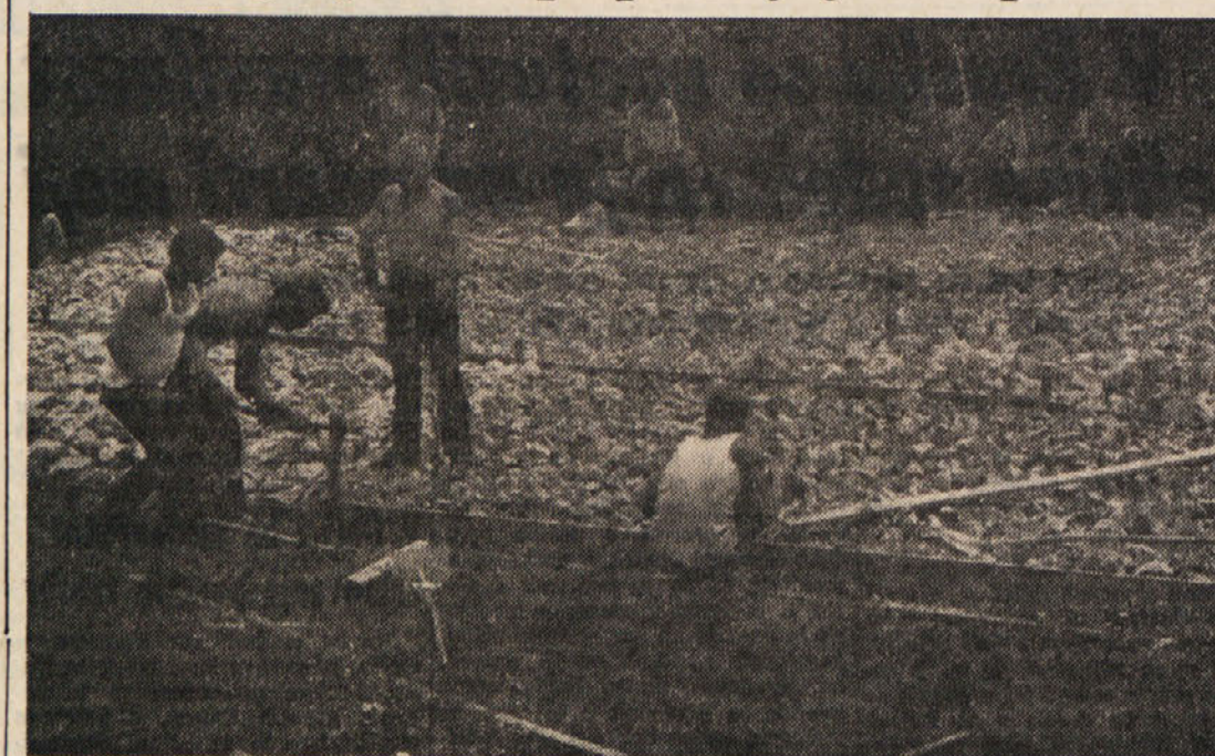
Fantje s Pregarj v Brkinih pripravljajo betonsko plesišče za bližnje opaslo
