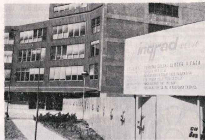
Tehniški šolski center Celje — začetek II. faze
