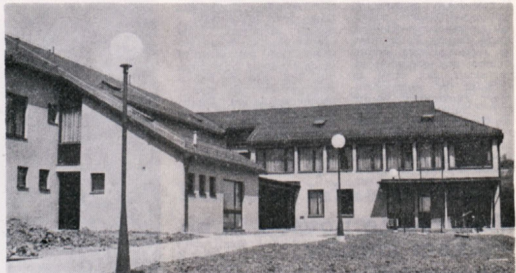
V teh zadnjih aprilskih dnevih delavci iz TOZD GO Laško zaključujejo dela na objektu Zdravstveni dom Štore, saj bo otvoritev v počastitev Praznika dela
