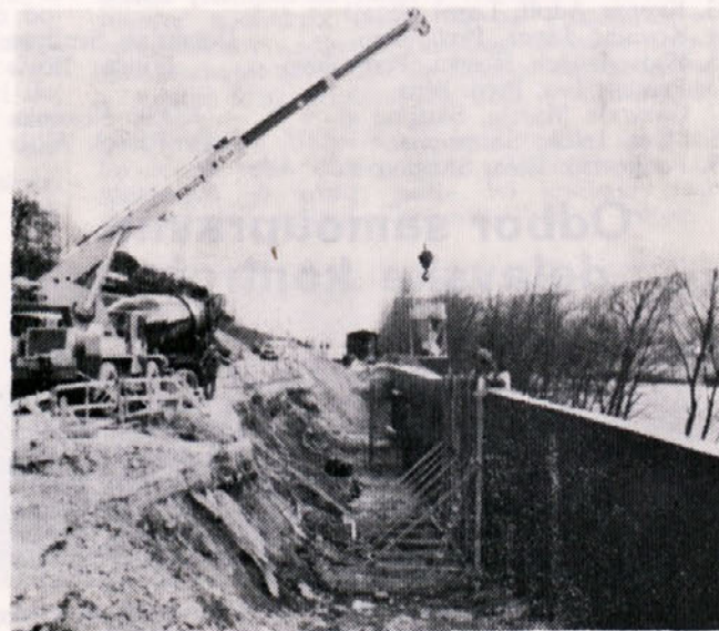
Betoniranje opornega zida ob Savi v Radečah
