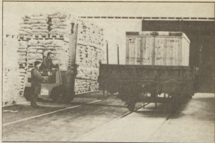
POMEMBEN VEZNI ČLEN integralnega transporta — To za nove skladiščne prostore Blagovno-transportnega centra Javnih skladišč v Murski Soboti gotovo lahko rečemo. Industrijski tir, ki je spetljan celo v pokrite prostore hale, vsekakor omogoča hitrejši in varnejši pretovor raznega blaga. Foto: N. Juhnov.
