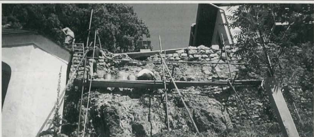
Sanacija "škarpe" na Gradu v Starem trgu pri Slovenj Gradcu leta 2002. Foto Branko Denovnik
