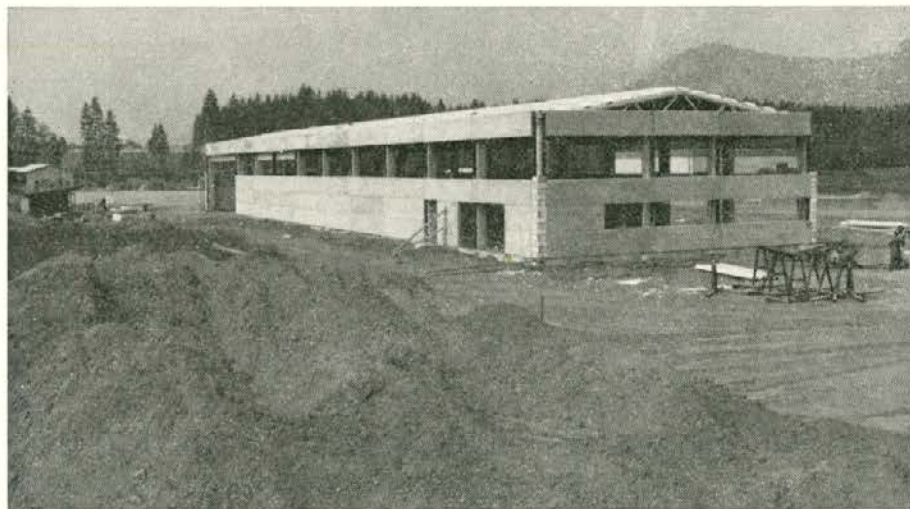
Žagalnica med gradnjo
