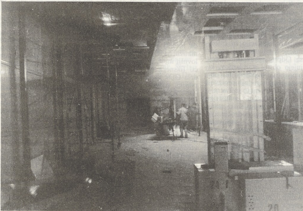
Dela v obnovljeni proizvodni hali
