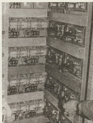
Končna nastavitev bremenske naprave ventilov drenažnega sistema
