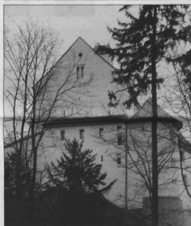
Grad s severozahodne strani
