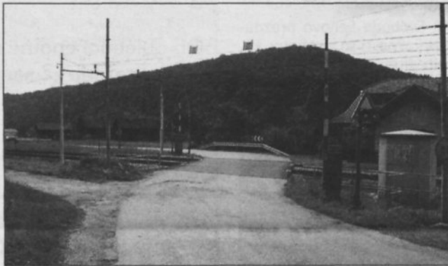
Nivojski cestno železniški prehod na Doljem Brezovem (vir: Občina Sevnica)
