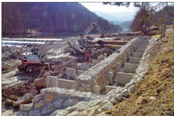
Na Delejevem jezu se gradi ribja steza, kar bo ribam omogočalo prehod. (Foto: IS)
