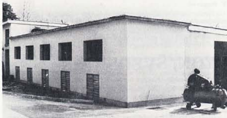
Razširitev kompresorske postaje
