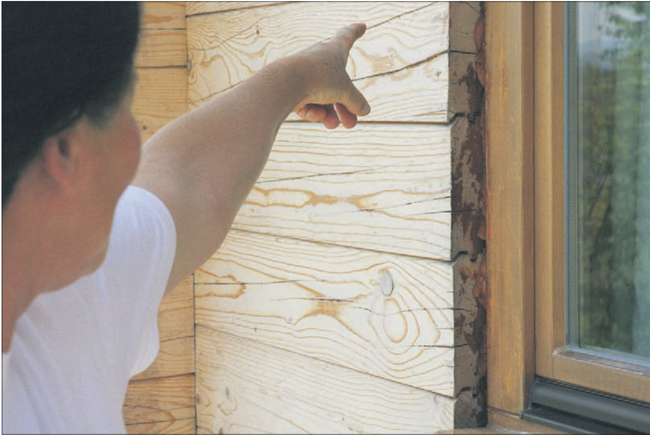
Lastnica hiše je prepričana, da bi moral tesar vstaviti slepe okvirje ali pa nanje vsaj opozoriti. Zdaj, ko na vseh koncih in krajih zvija okna in vrata, graditelj hiše pravi, da to pač ni njegova stvar.
