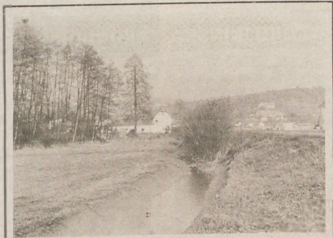
Če ne bi bilo močnega deževja, sploh nihče ne bi opazil, da so delavci VGP iz Maribora začeli z izsuševalnimi deli pred regulacijo Ščavnice in ne obratno. Ali so novoizkopani jarki povzročili poplavo v naselju Spodnja Ščavnica ali pa so jo ublažili?
