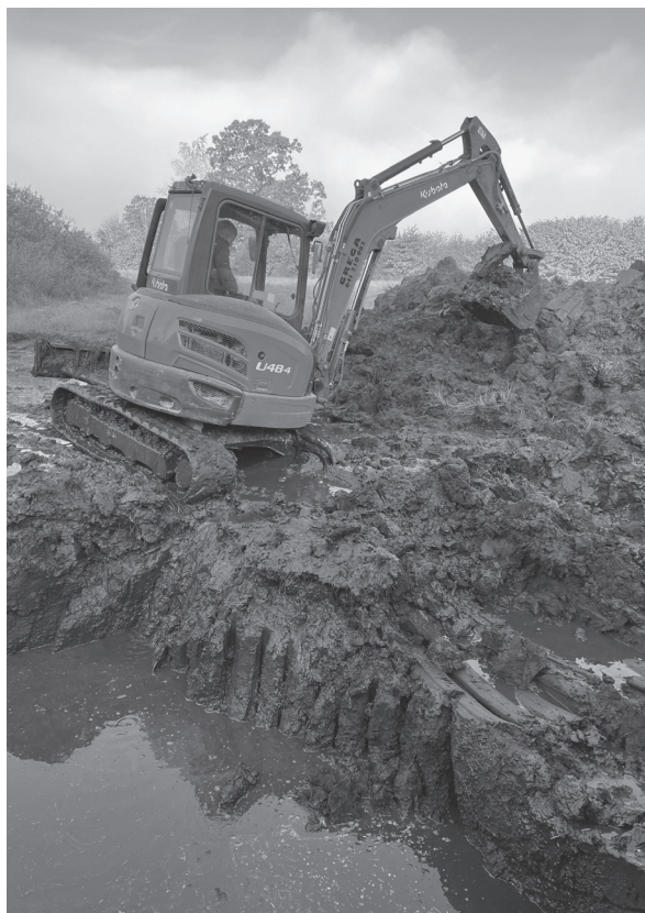
Slika 8: Visok nivo podzemne vode je na nekaterih lokacijah močno oteževal izkop. Mlaka se je že v času del izdatno napolnila z vodo. (Foto: P. Golob)
