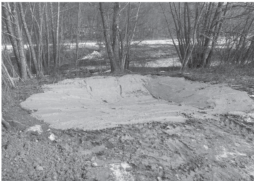
Slika 2: Dno mlake na Radenskem polju smo za zagotavljanje vodotesnosti utrdili z nanosom plasti gline. (Foto: P. Golob)
