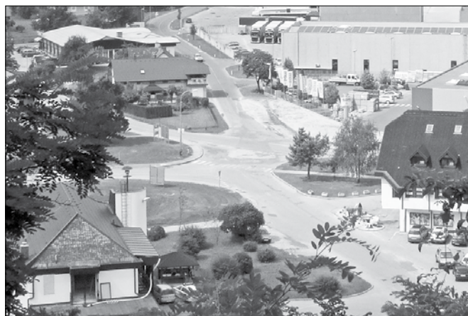
Na stičišču Zadrecke, Savinjske in Lesarske ceste bo celjsko podjetje VOC v kratkem začelo z izgradnjo krožišča. (Foto: Igor Solar)
