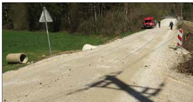
Dela potekajo na odseku od grušovljanskega mostu do odcepa proti Zgornjim Pobrežjam. (Foto: Marija Lebar)
