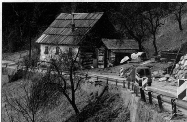
Lučani bodo morali najti rešitev za staro hišo, ki se nahaja na sredini predvidene trase za izgradnjo Logarskega mostu (foto: EMS)
