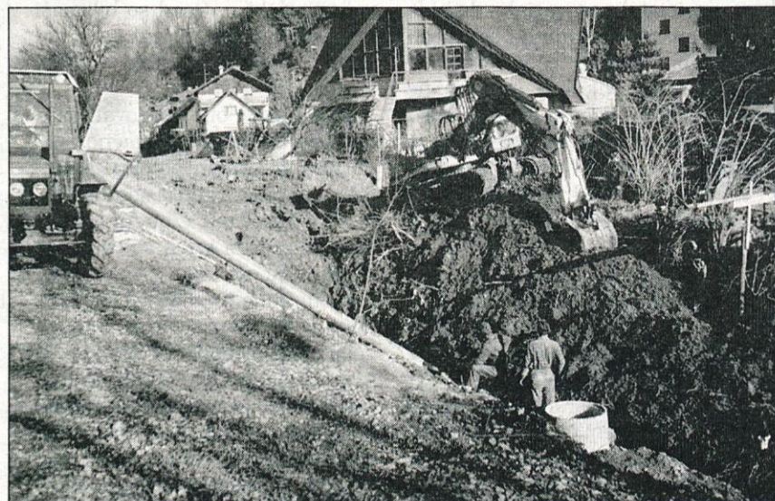
Polaganje primarnega kanalizacijskega voda ob železnici. Trgograd d.o.o. opravlja zahteven izkop pred stanovanjsko hišo Jožeta Grila na Graški cesti.
