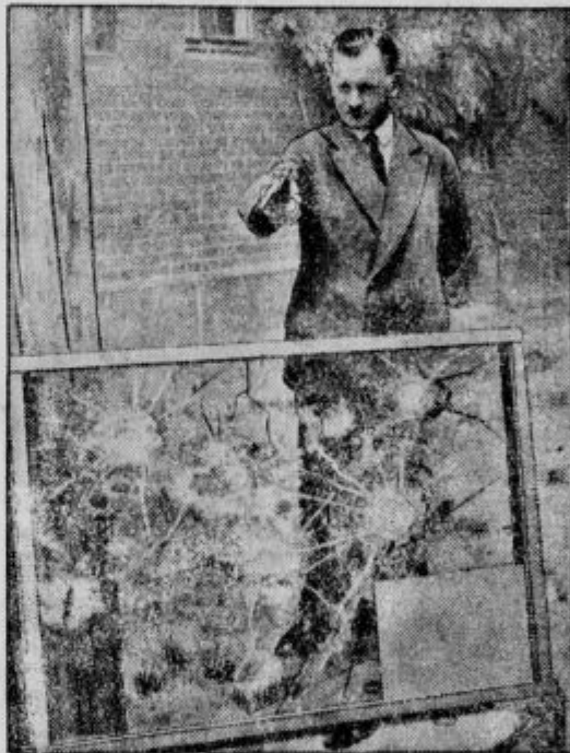
Neprestreljivo steklo. Na policijskem kemičnem institutu v Berlinu preizkušajo steklene plošče, ki jih tudi 9 mm krogla ne prestreli.
