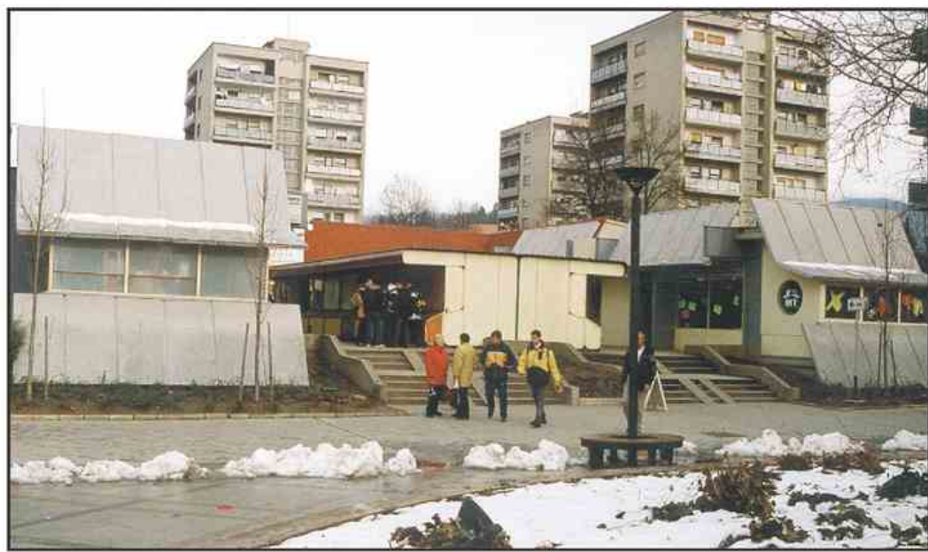
Objekt na Cankarjevi naj bi povsem porušili, na tem mestu pa zgradili novega. V njem bodo med drugim uredili tudi mestno tržnico.
