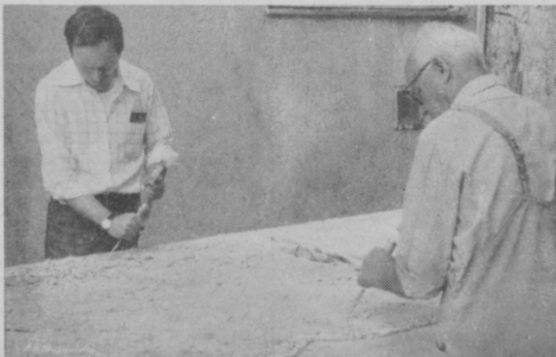
Odstranjevanje antičnega nosilca
