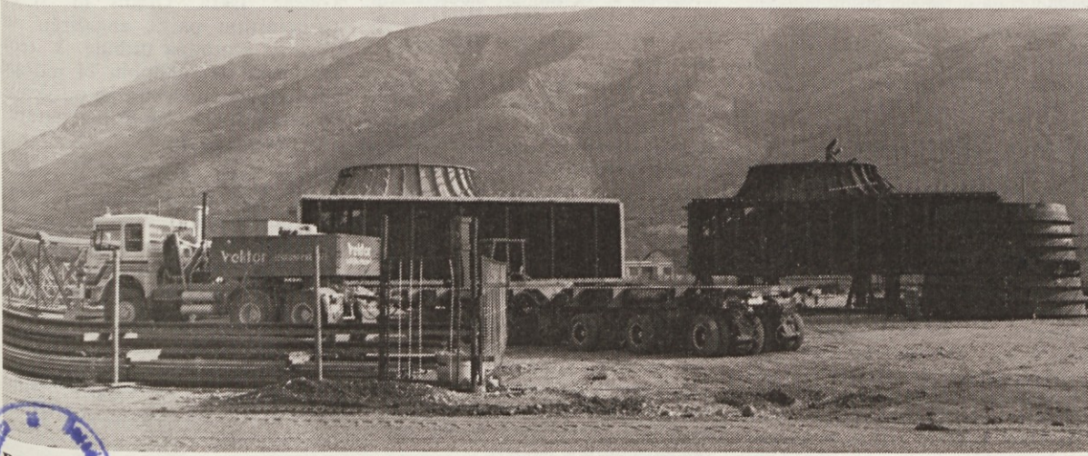
Pogled na sesalne cevi na deponiji za DE Mostar. V ozadju sta Prenj in Velež
