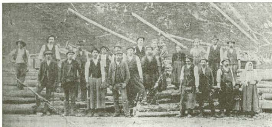
Slika je nastala leta 1910, ko so gradili žlebove na suhodolško žago.
