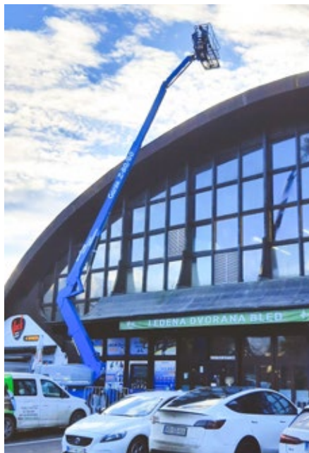
Ledena dvorana Bled - sanacija strehe
