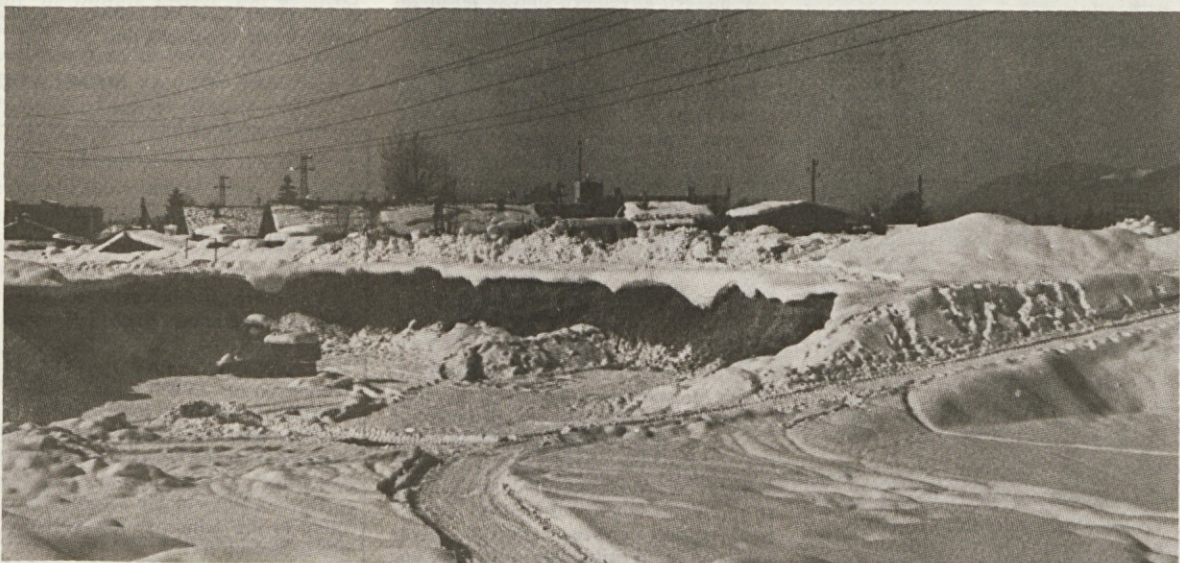
Profil ceste je že skopan do Korotanskega naselja, ki je ena izmed mnogih ovir na tej obvoznici. Doslej je vsa dela omogočala topla in suha zima, sedaj pa jih je, upajmo da ne za dolgo, ustavila zapoznela snežna odeja (Foto: E. L.)
