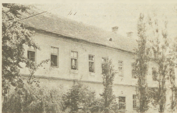
Stara osnovna šola in višja gimnazija že dolga leta propada. V njej je sedaj sedem stanovanj, z obnovo pa bi jih lahko bilo več.
