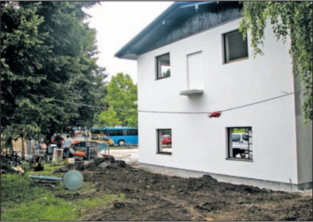
Za zdaj jeo kolicagas ilskega doma šer azkopana, a ne bod olgo.
