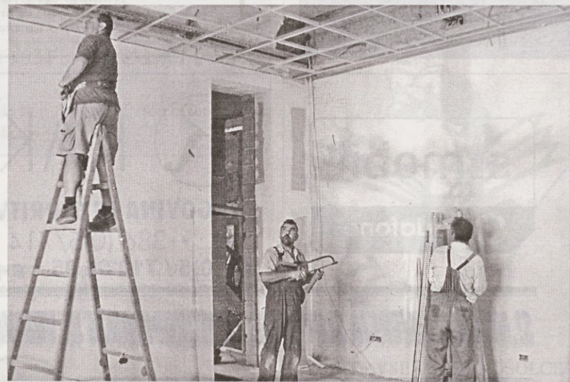
Delavci hitijo z urejanjem prostorov v 1. nadstropju stavbe nove gimnazije. Kot je povedal župan, delajo v dveh izmenah, podnevi in ponoči, da bi vsaj prvo nadstopje končali do začetka šolskega leta.
