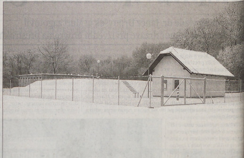
Gradnja čistilne naprave na Srednji Bistrici je končana in čaka na otvoritev. To se bo zgodilo predvidoma aprila. (Foto: J. G.)
