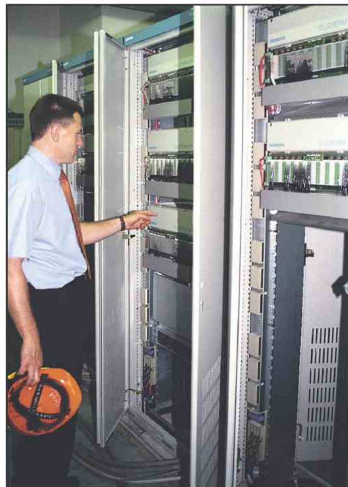
Mag. Uroš Rotnik pred elektro omaricami - iz njih v tem času demontirajo električne kable. Skupaj jih bodo demontirali in na novo zmontirali 50 kilometrov
