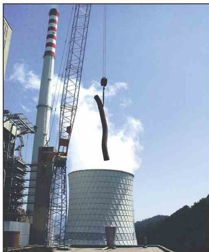
Pri spravljanju tovorov na blok si pomagajo z 200-tonskim dvigalom.
