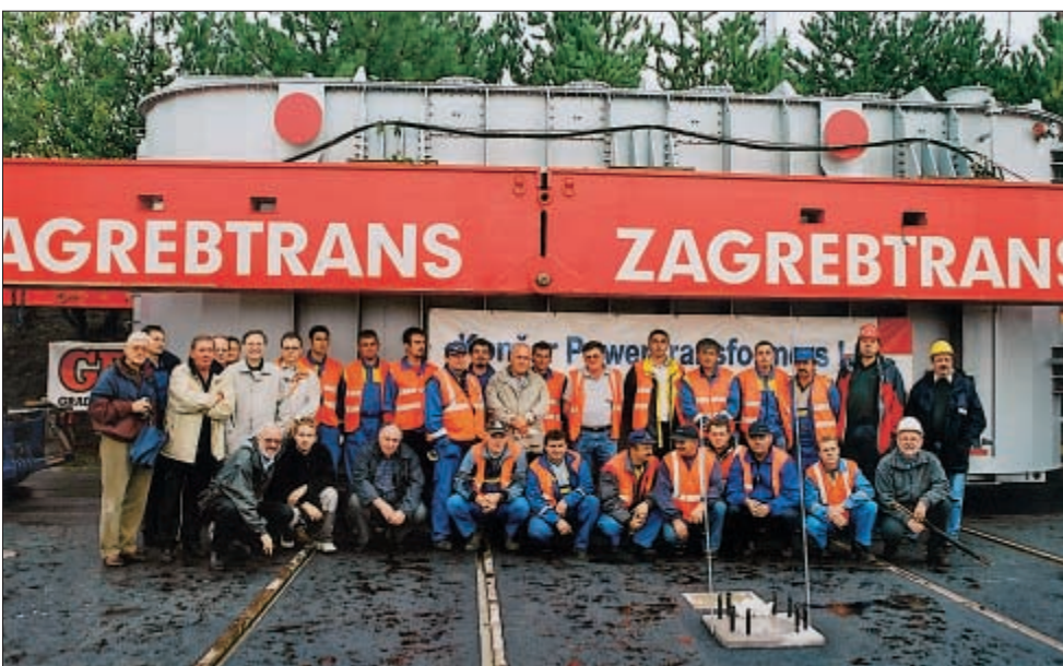
Sodelujoči in glavni akterji naložbe na cilju popotovanja transformatorja od Zagreba do Divače pred temelji zanj v RTP Divača.
