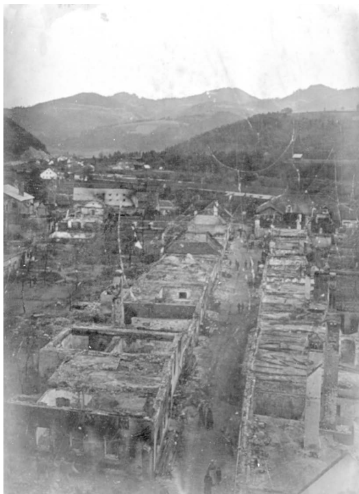
Po požaru Meškove ulice 1903
