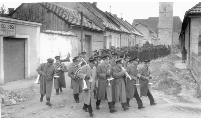
Za vodovod razkopana ulica ob pogrebu Angele Mitnjek, 1958
