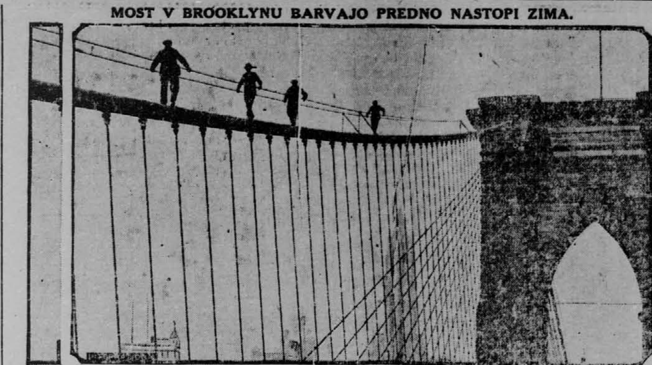
Slika predstavlja, kako delavci barvajo veliki most v Brooklynu. Delavci in nadzorniki so izpostavljeni veliki nevarnosti pri tem opravilu.
