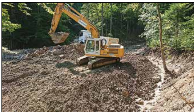
Odstranjevanje grušča iz zaplavnih pregrad na Bočnici (fotodokumentacija JP Komunala Gornji Grad)
