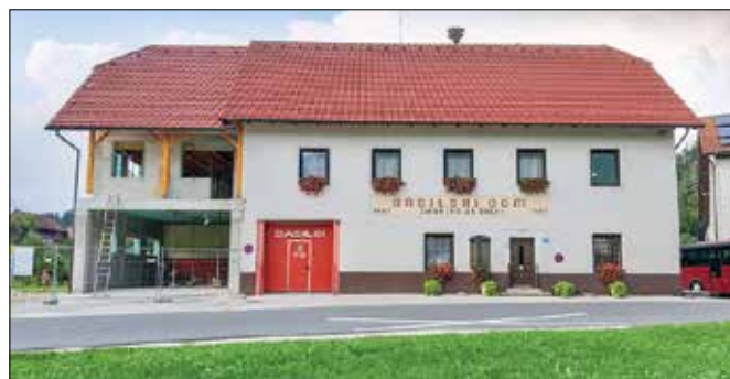
Da so objekt kar se da izkoristili, so nad garažo zgradili še dve etaži. (Fotodokumentacija PGD Šmartno ob Dreti)
