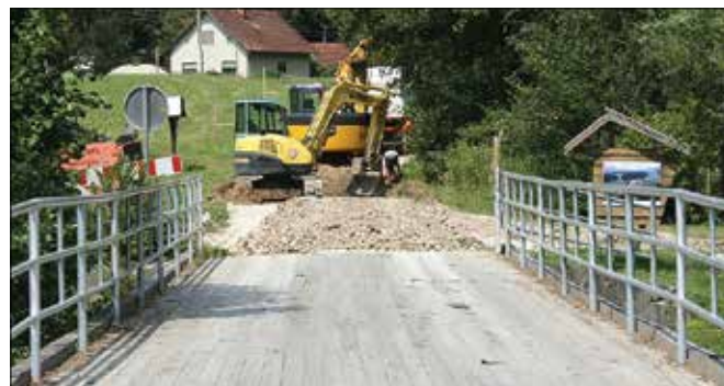
Na odseku ceste od mostu čez Dreto proti Brdu so se dela začela prejšnji teden. (Foto: Marija Lebar)
