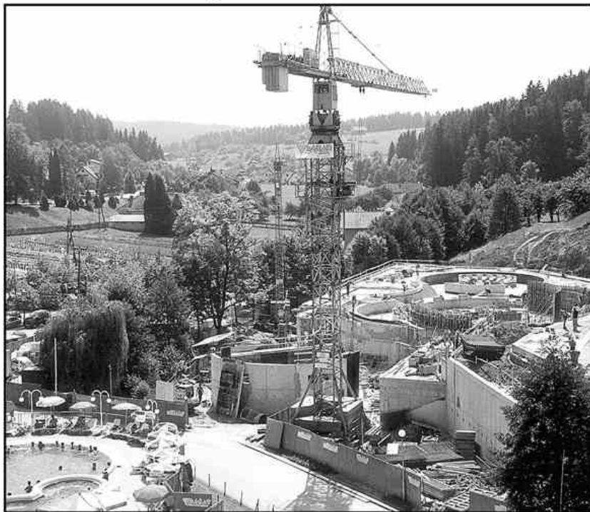
Danes gradbišče, konec prihodnjega meseca lepo urejen termalni park s tremi bazeni in toboganom.
