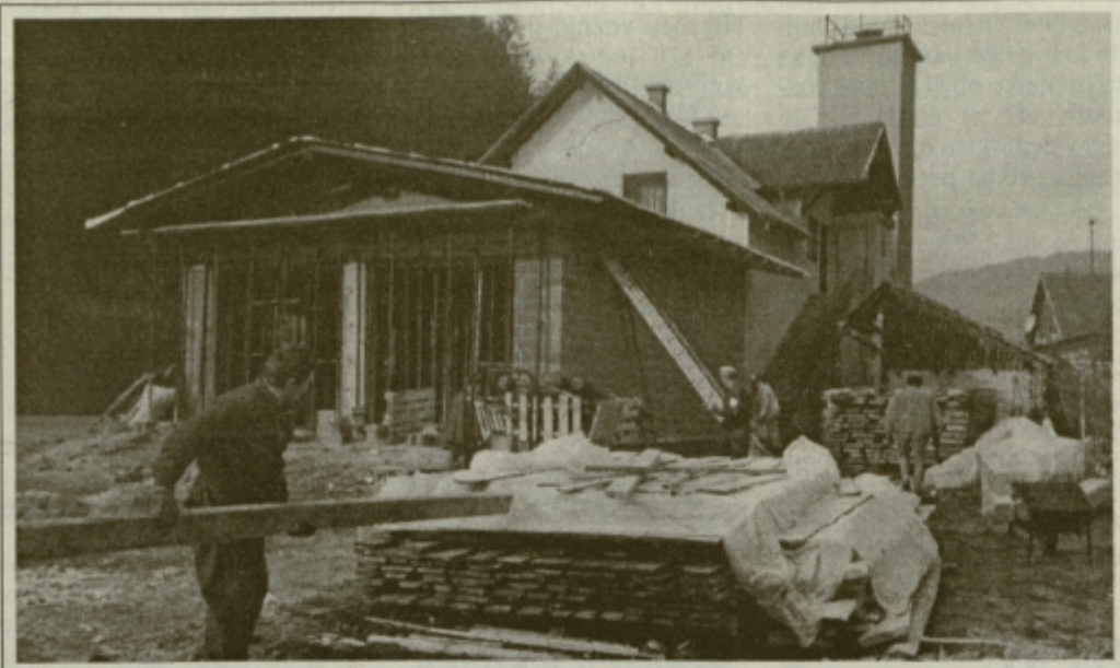
Prizidek h gasilskemu domu v Rečici pri Laškem med gradnjo.
