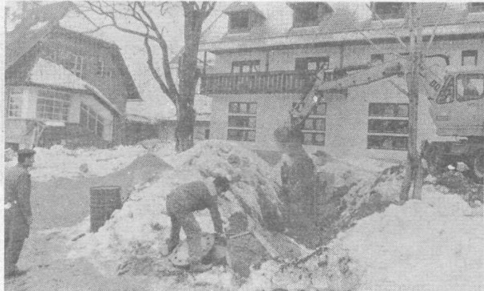
Gradnja na Rakitni se bliža koncu
