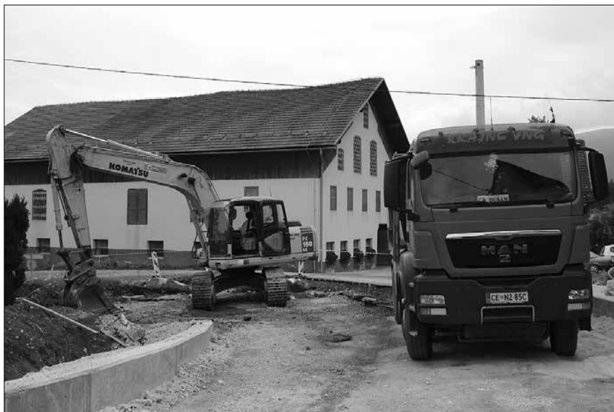
Starega mosta v Bočni ni več, gradnja novega se je pričela v tem tednu. (Foto: Štefka Sem)
