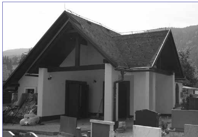
Prenova mrliške vežice v Lučah je skoraj zaključena. (Foto: Marija Lebar)
