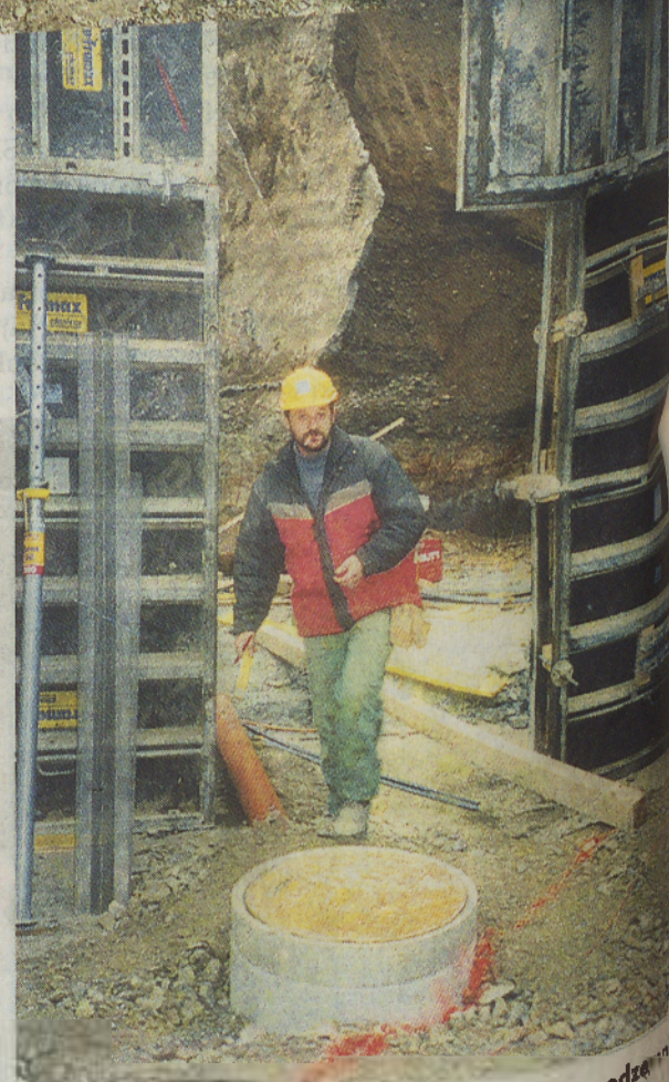
»Tole sem v delovni opravi na gradbišču podzemnih garaž pod središčem avstrijskega Gradca.«
